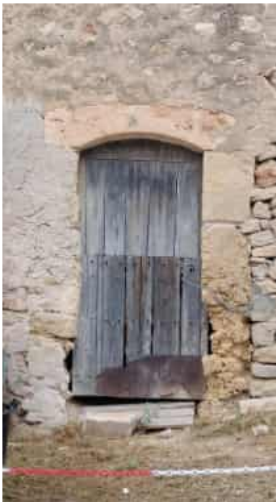
Im. 5: Vista portal accés al magatzem del molí. Brancals i llindar a reparar i condicionar.
