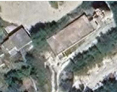
Caseta de cloración
