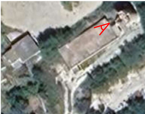
Vista de la parte superior del depósito
